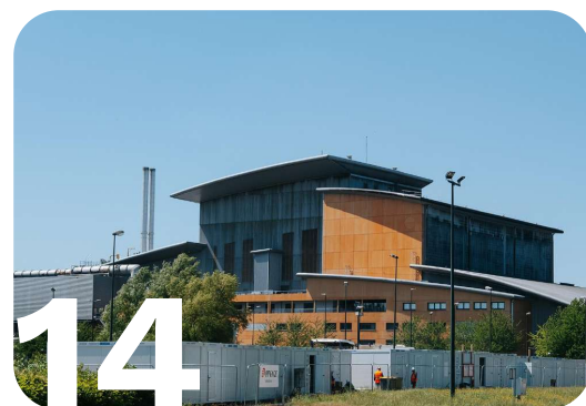
14 Unités de Valorisation Énergétique des Déchets
